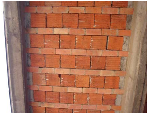
Blick in einen Dachvorstand (nördlichstes Gebäude der östlichen Gebäudereihe) mit defektem Ziegelmauerwerk (Juli 2009)
